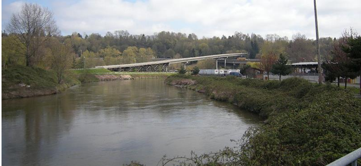
L'Archie Codiga Bridge
