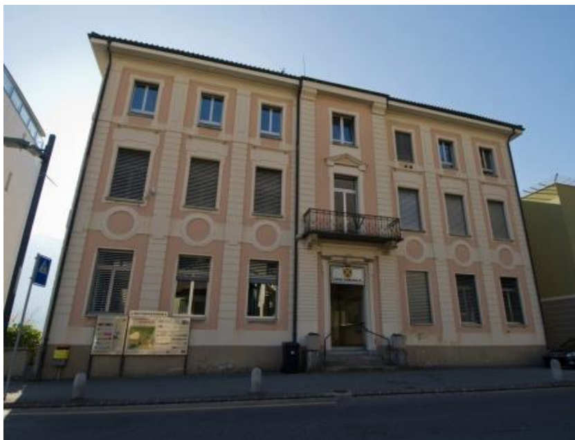
Il Palazzo Comunale di Gordola, ex Scuole ora sede del Municipio (fotografia copiata dal semestrale "Comune di Gordola")
