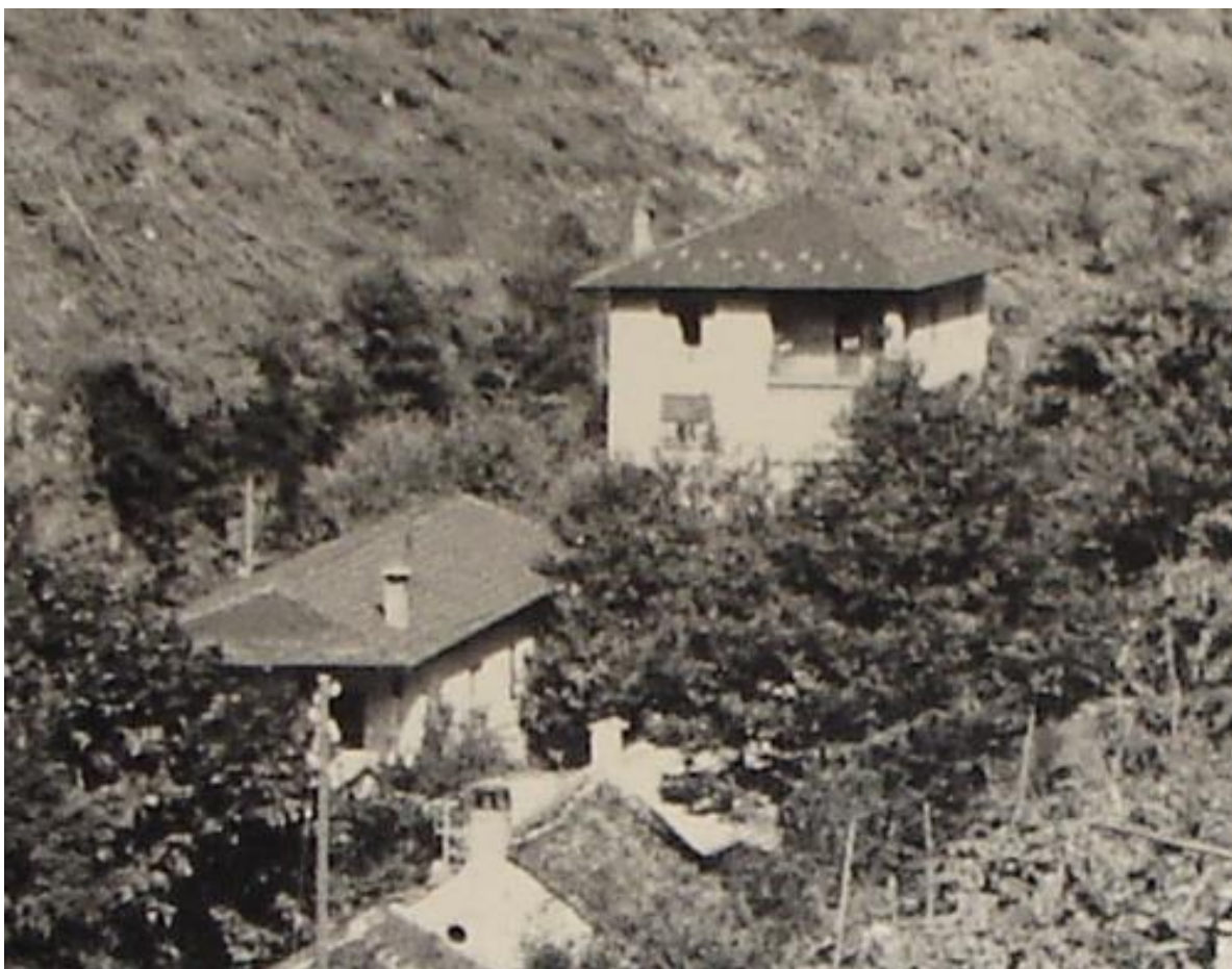
Una parte delle case di abitazioni sacrificate e demolite.
