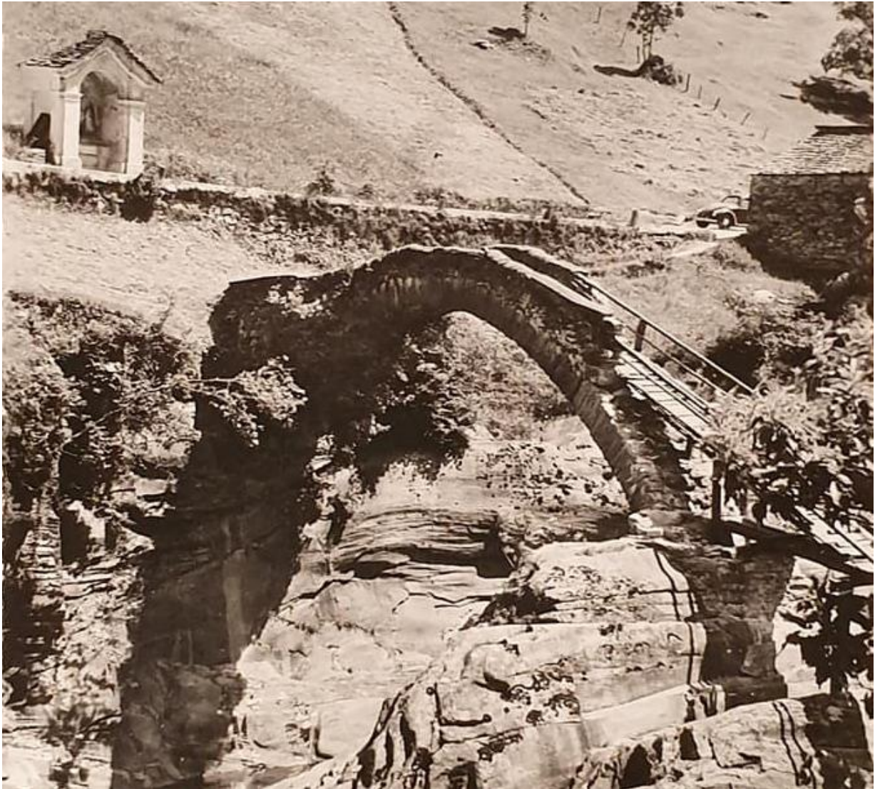
Il così detto "Ponte dei salti" a Lavertezzo dopo un alluvione
