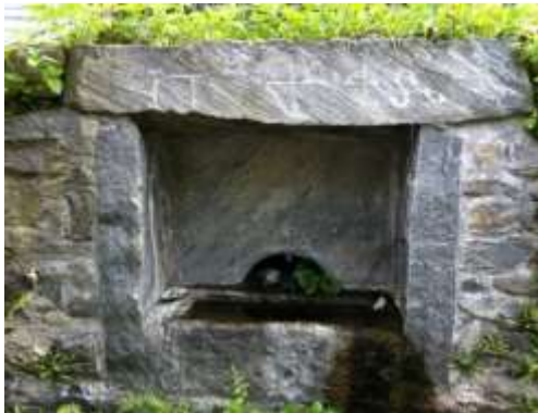
Fontana a casa Pisciani a Corte Sopra opera di Ernesto Bisi e costruita con un "baröz da sas" e con l'architrave in sasso di una porta
